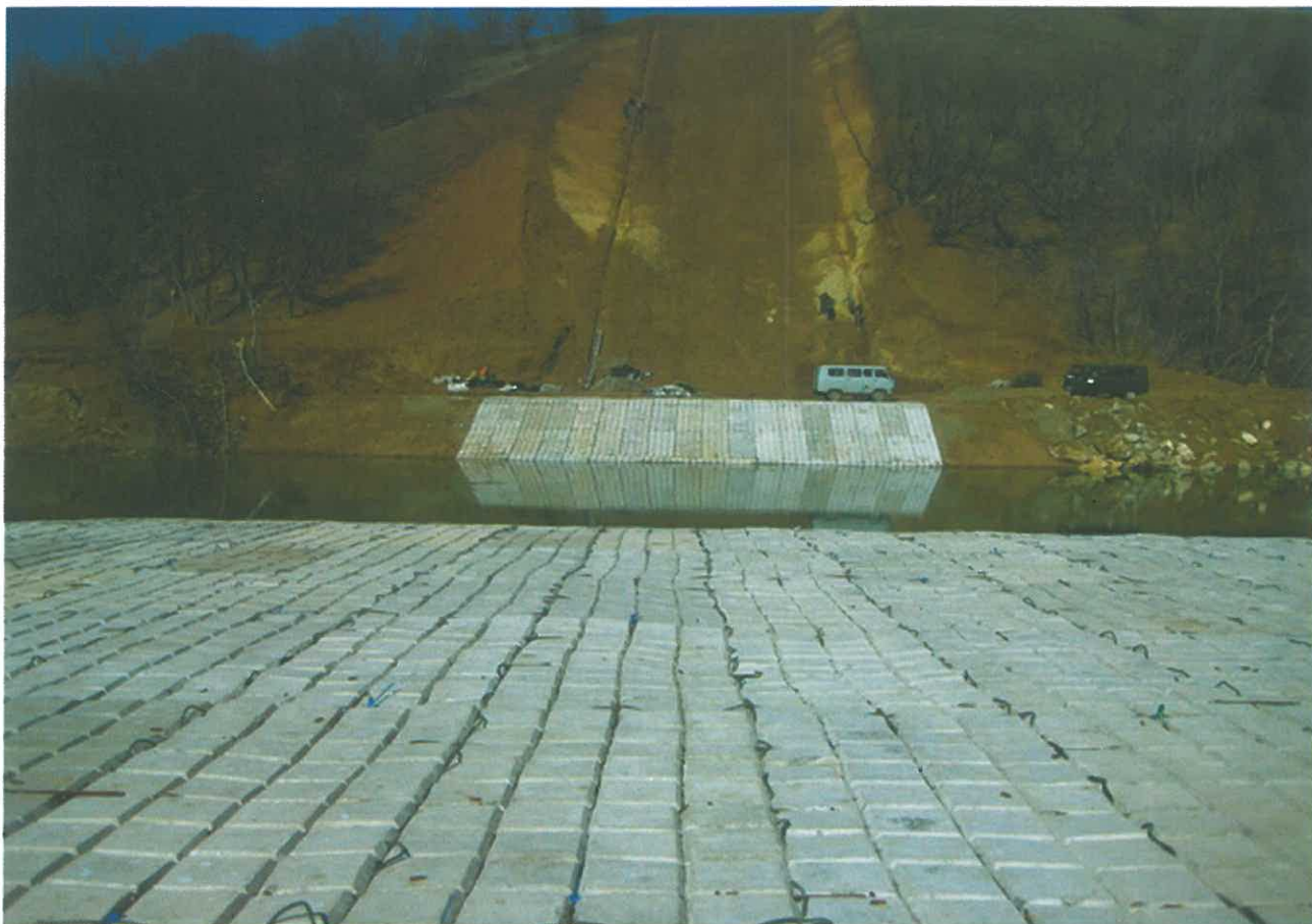
Фото 1. Гибкое бетонное покрытие (ГБП) с торчащими монтажными петлями, скрепленное скобами
