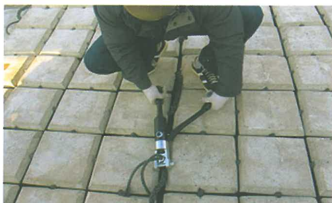
Фото 4. Скрепление ПБЗГУ путем обжима кольца, надетого за крепежные концы
